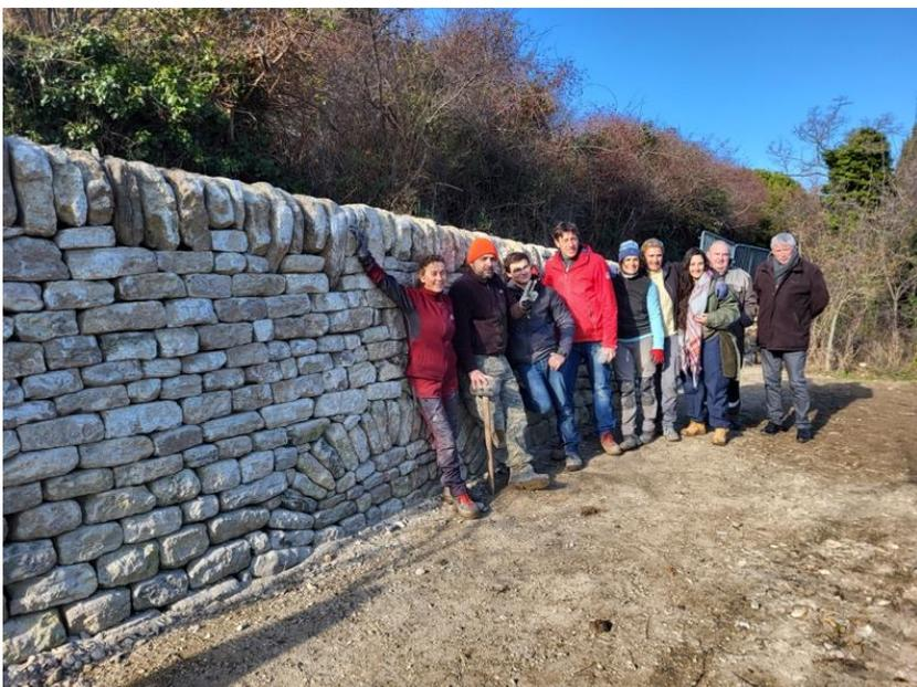
« Les Muraillers de Provence », association en partenariat avec le centre de formation professionnelle de promotion agricole Provence-Ventoux-Carpentras, ont achevé fin janvier, la reconstruction du mur de soutènement en pierres sèches du chemin du Bourget. Réalisé avec 6 stagiaires de la formation, ce mur long de 13 mètres sur 2 mètres de haut, présentait à sa base une citerne dont la voûte en pierre a été restaurée.
