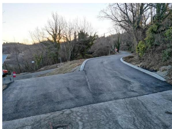
Les travaux sur le carrefour route de Castellet/ route de l'abbaye ont permis la mise en sécurité par une amélioration de la visibilité. L'enfouissement d'une ligne téléphonique et la suppression des poteaux ont été également réalisés.
